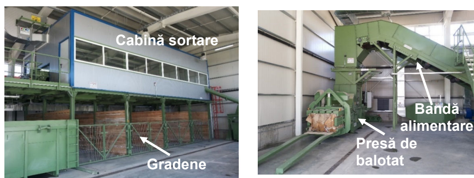
Figura 4.9. Imagini din Stația de sortare lanca
